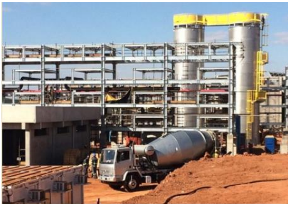
Foto do Pipe Rack da Unidade/Edificações Premoldadas e Bases de Equipamentos
