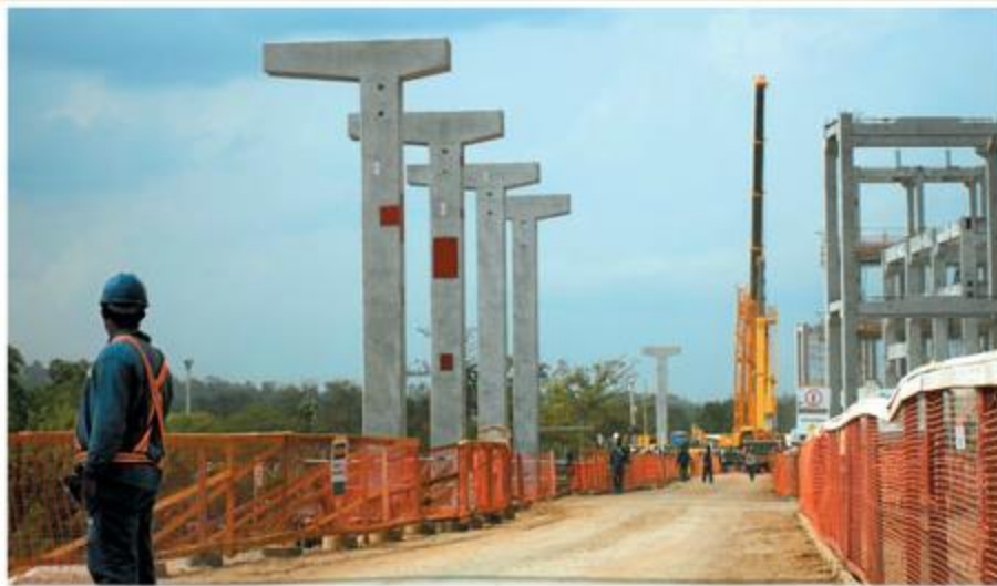
Tubovia na RLAM | CONSÓRCIO INTEGRAÇÃO | Pilares com peso de 60t
