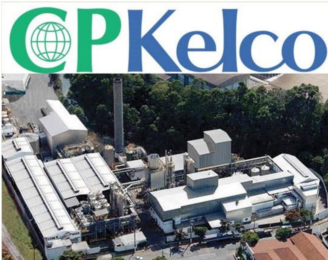
AMPLIAÇÃO DA UNIDADE LIMEIRA - SP
