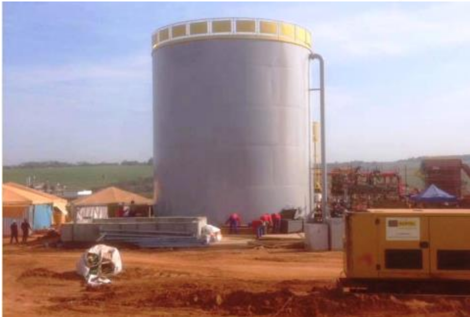
Bases de Equipamentos Estaqueadas
