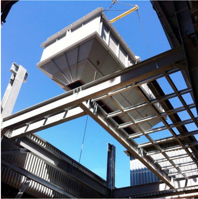
ESTRUTURAS METÁLICAS PARA PRÉDIO DAS PRENSAS
